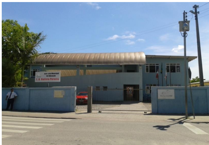
Figura 1: Fachada da Escola Básica Municipal Batista Pereira. Fonte: da autora, 11 de novembro de 2014.
